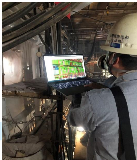
【圖 3】 現場工程師使用 Navisworks 進行 LINE CHECK
